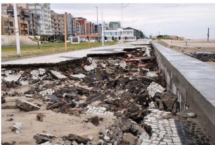
Figura 4-13: Erosão do calçadão de Capão da Canoa devido à fixação de uma praia dominada por ondas.
