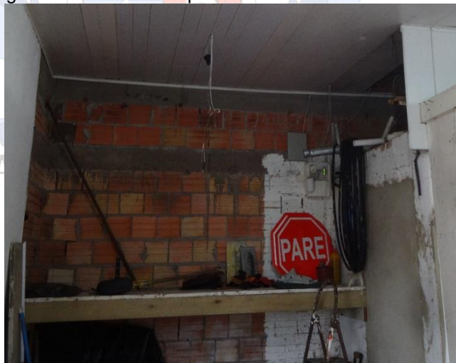
Figura 04: Detalhe das paredes sem acabamento no local
