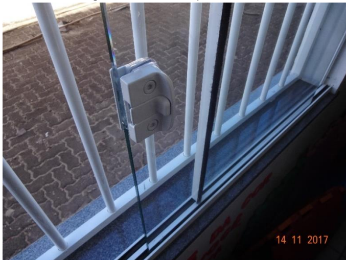
Figura 03: Detalhe padrão da fechadura
