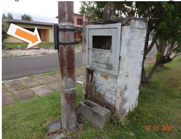
Figura 07: Detalhe da atual medição e da antiga
