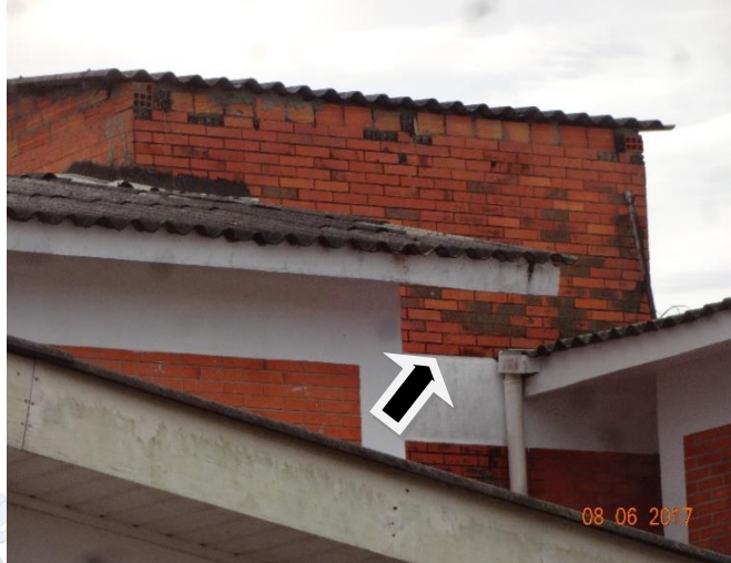
Figura 02: Detalhe da parede para revestimento no entorno do reservatório
