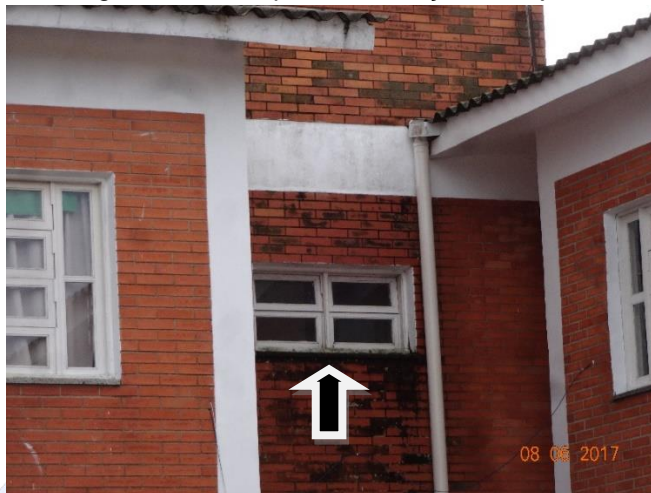
Figura 04: Local para a execução dos tijolos de vidro
