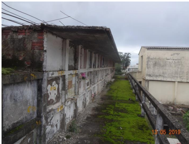
Parte da laje a ser demolida
