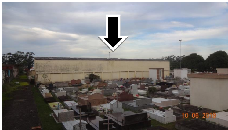
Telhado a ser recuperado
