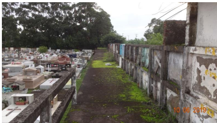
Parte a ser construído a continuação do guarda corpo
