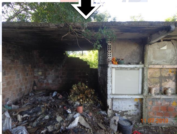
Parte da laje a ser demolida
