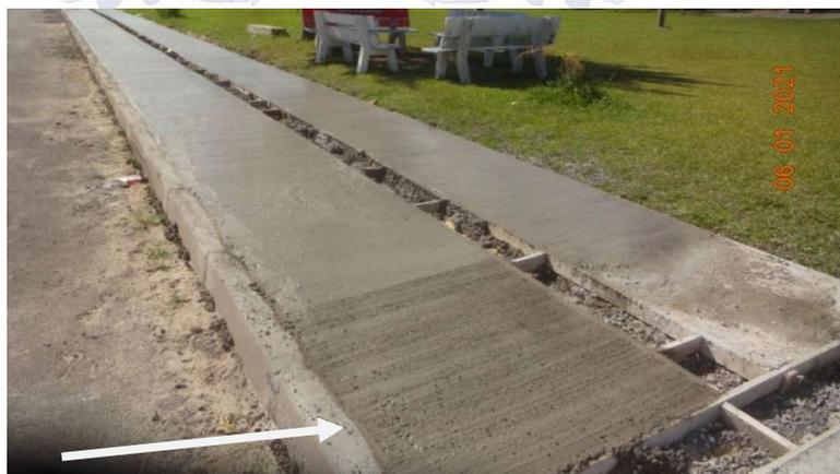
Figura 03 – Acabamento no concreto com vassourão
