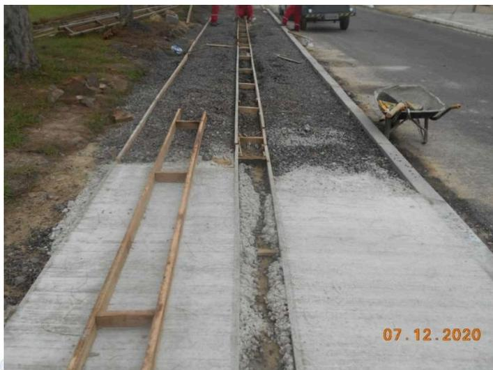
Figura 02- Detalhe concretagem passeio
