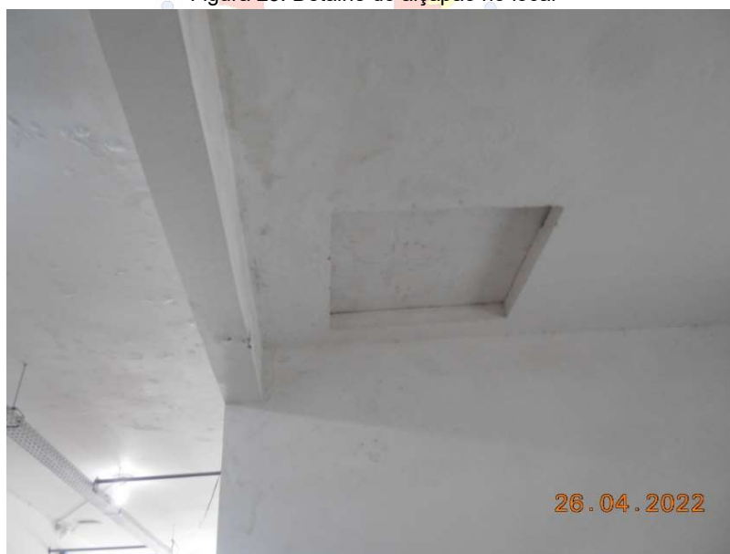
Figura 25: Detalhe do alçapão no local
