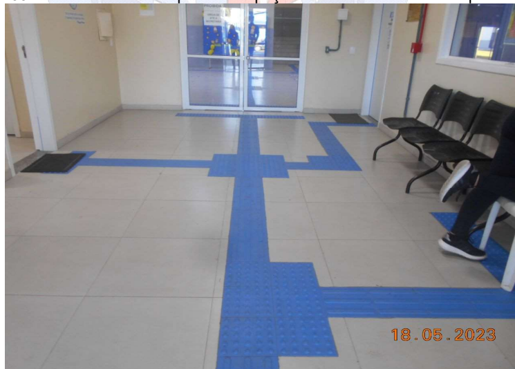
Figura 03: Detalhe do modelo padrão de peças de borracha sobre a superfície do piso
