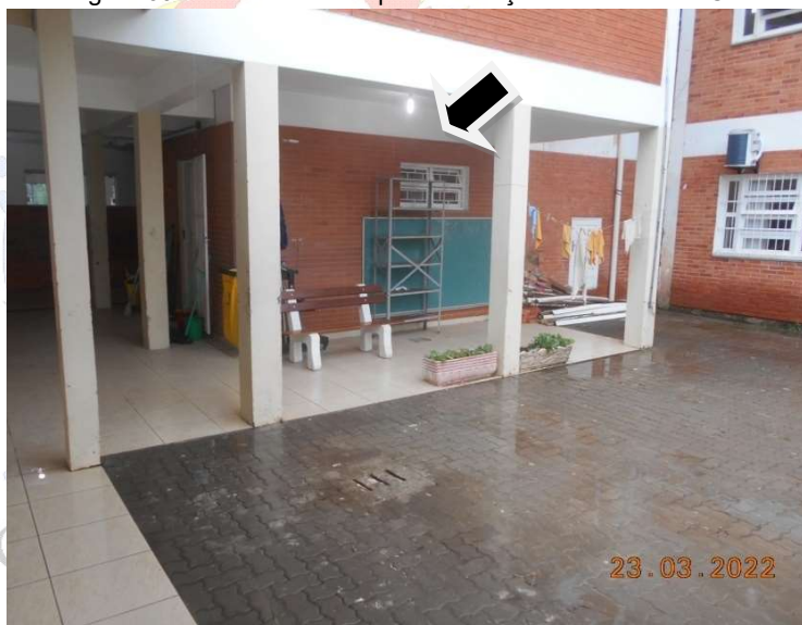
Figura 09: Detalhe do local para execução do sanitário PCD
