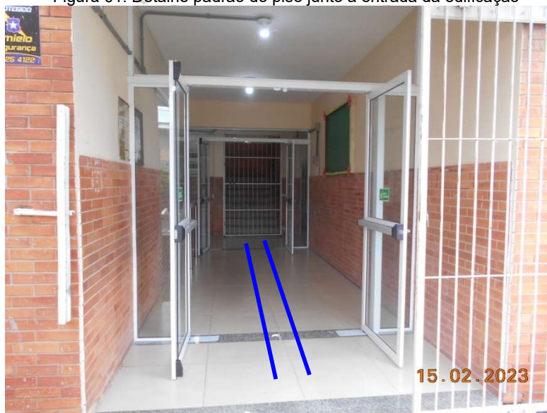
Figura 01: Detalhe padrão do piso junto à entrada da edificação
