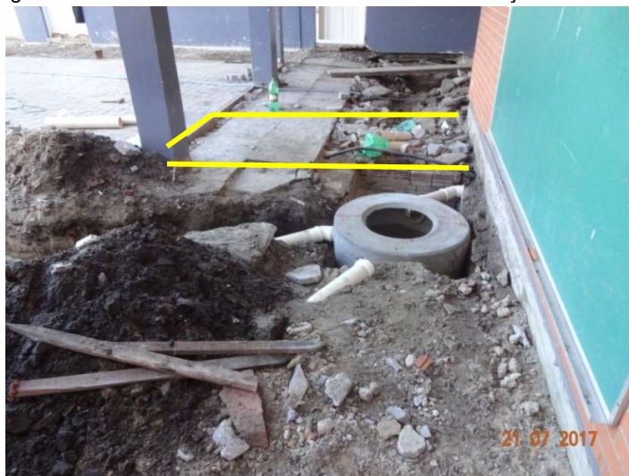
Figura 10: Detalhe da fossa existente no local de execução do sanitário PCD
