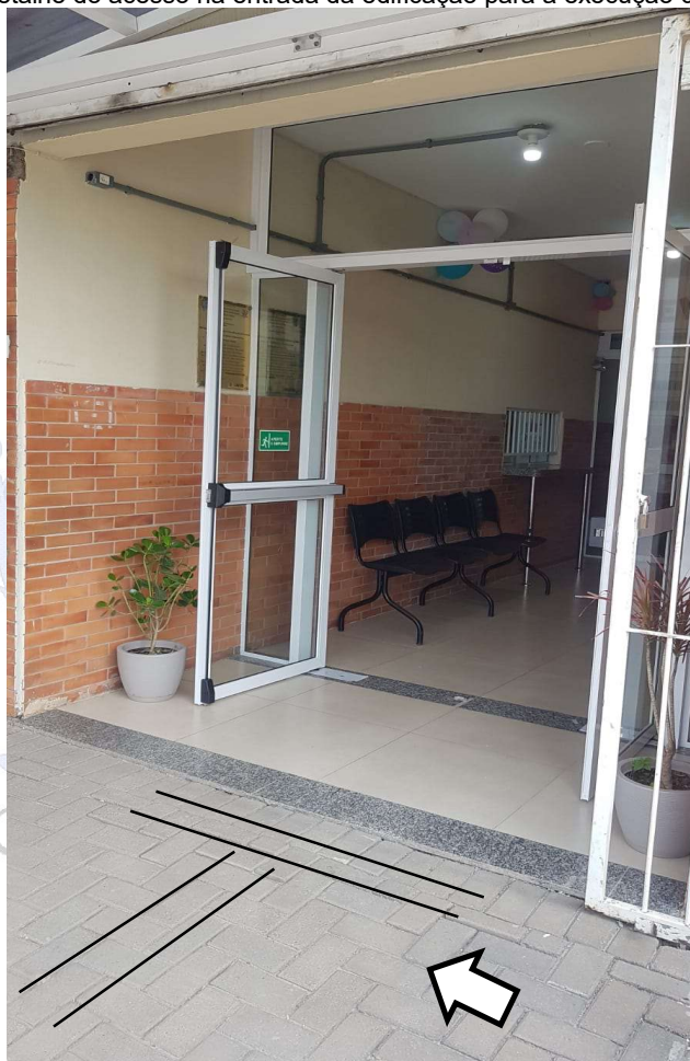
Figura 05: Detalhe do acesso na entrada da edificação para a execução do piso tátil
