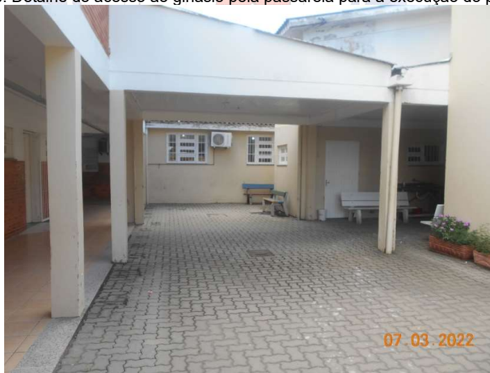
Figura 06: Detalhe do acesso ao ginásio pela passarela para a execução do piso podo tátil
