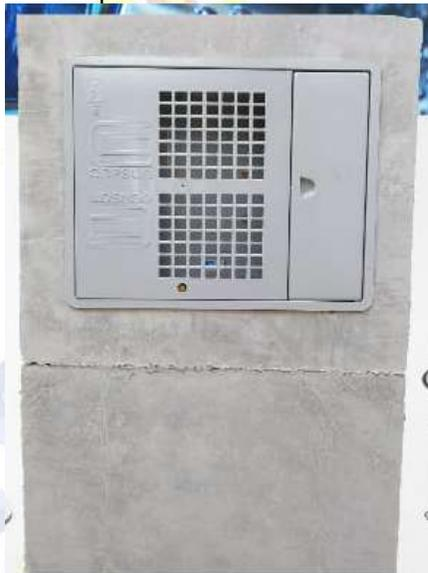
Figura 03: Detalhe da peça pré-moldada para inserção da caixa padrão
