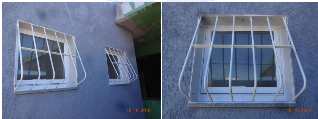
Figuras 17 e 18 – Modelo das grades galvanizadas a fogo (janelas basculantes).
