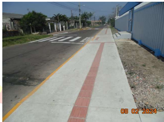
Figuras 06 e 07 – Modelo de piso do passeio em concreto polido
