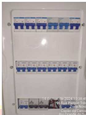
Figura 21 – Exemplo de identificação dos circuitos elétrico do quadro de distribuição interno
