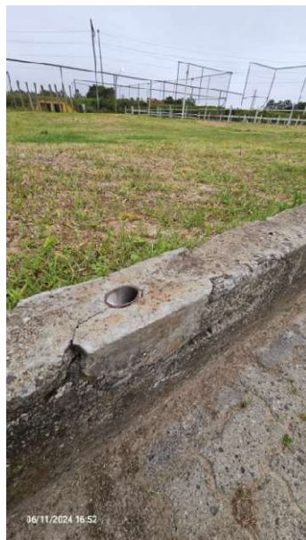
Figuras 08 e 09 – Pontos que devem ser demolidos com rompedor para retirada dos tubos e reparada a viga de contenção.
