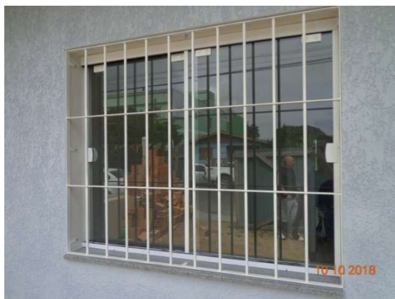
Figura 16 – Modelo das grades galvanizadas a fogo
