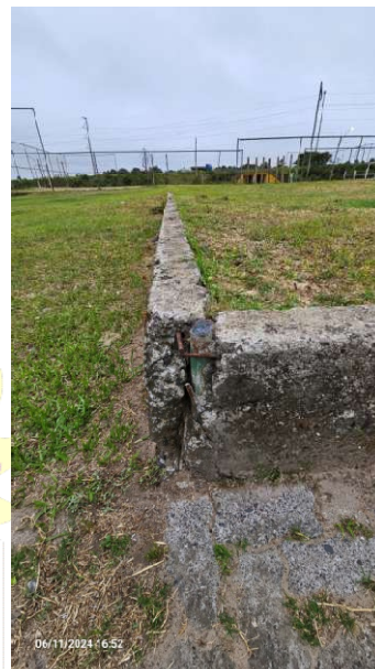
Figuras 08 e 09 – Pontos que devem ser demolidos com rompedor para retirada dos tubos e reparada a viga de contenção.
