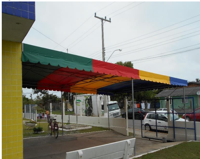
Figura 01: Detalhe do toldo antes da ocorrência do evento
