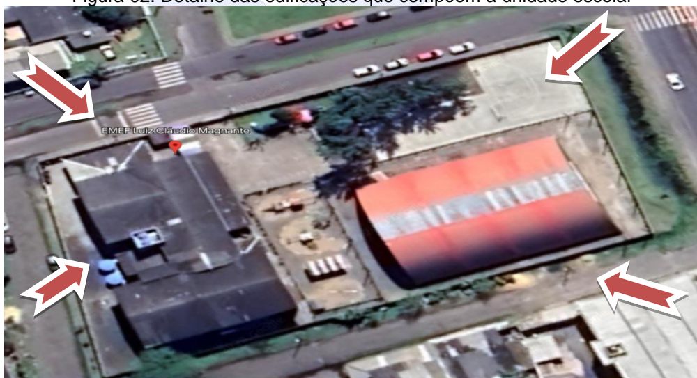
Figura 02: Detalhe das edificações que compõem a unidade escolar
