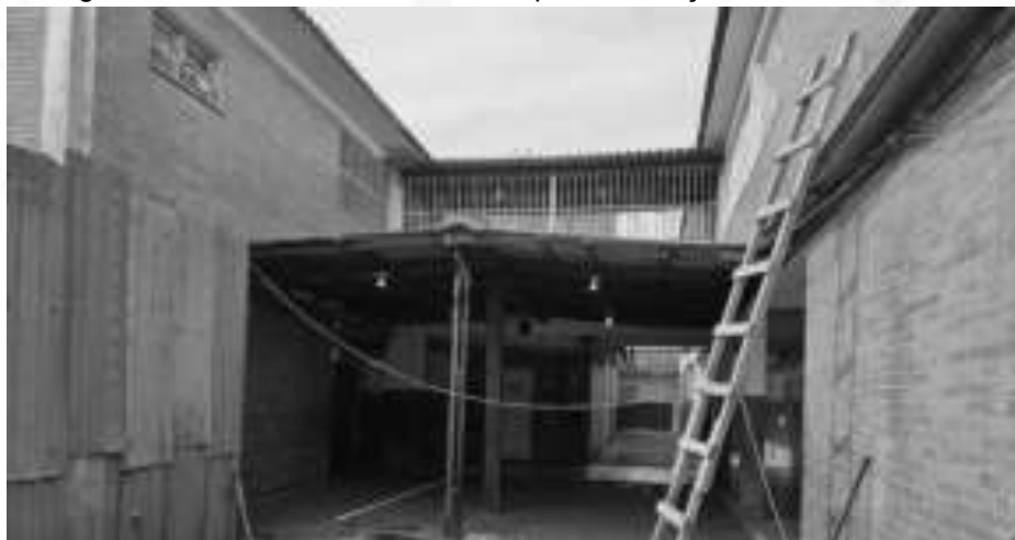
Figura 01: Cobertura a ser removida para instalação de nova cobertura
