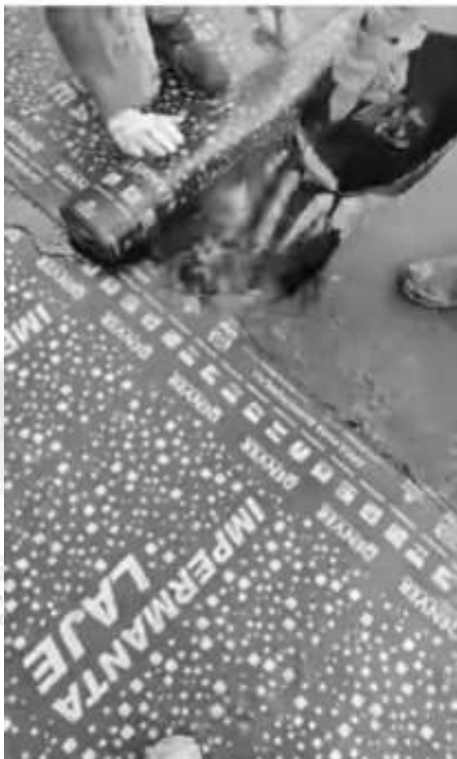
Figura 5: processo de aplicação da manta asfáltica
