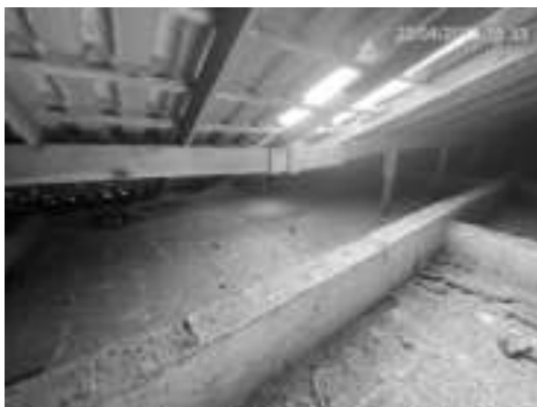
Figura 4: Parte do telhado que deve ter o madeiramento substituído
