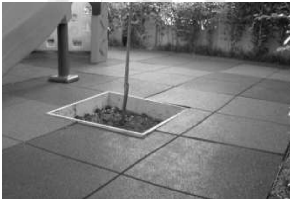
Figura 21: Detalhe ilustrativo do piso de borracha
