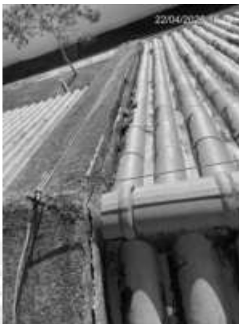
Figura 11: rufo em concreto com enchimento
