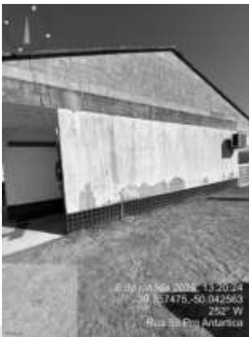
Figura 17: pastilhas já removidas
