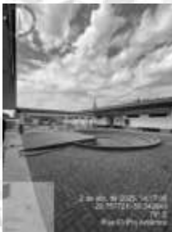
Figura 23: Anfiteatro que terá o piso nivelado;
