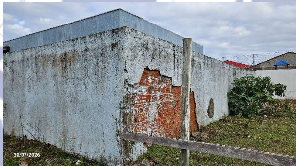
Situação atual dos muros existentes
