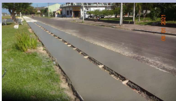
Modelo de concretagem de calçada, com gabarito para o piso tátil
