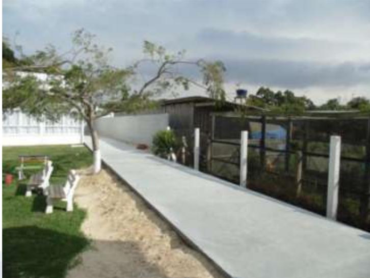
Figura 04: Detalhe de pavimento de concreto polido com piso tátil
